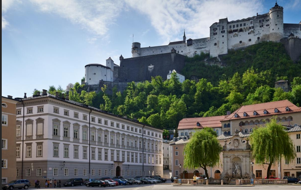
Erzbischöfliches Palais Salzburg – Umbau Erdgeschoss 2013
